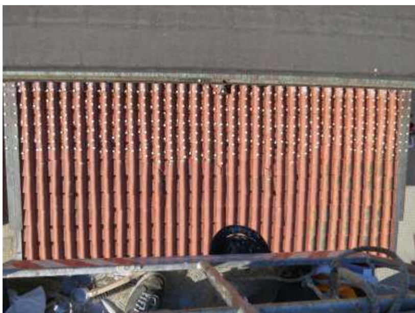
Figura 5. L'area del tetto sud trattato con Bird Free era di circa 9m x 1,8m
