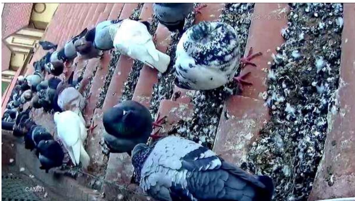
Figura 2. Tetto sud prima del tramonto (18:33) 26 marzo 2017, tre giorni prima dell'installazione di Bird Free.
