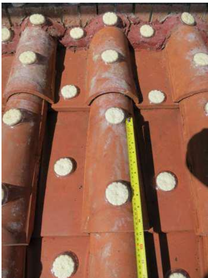
Figura 4. Tetto sud trattato con Bird Free .
