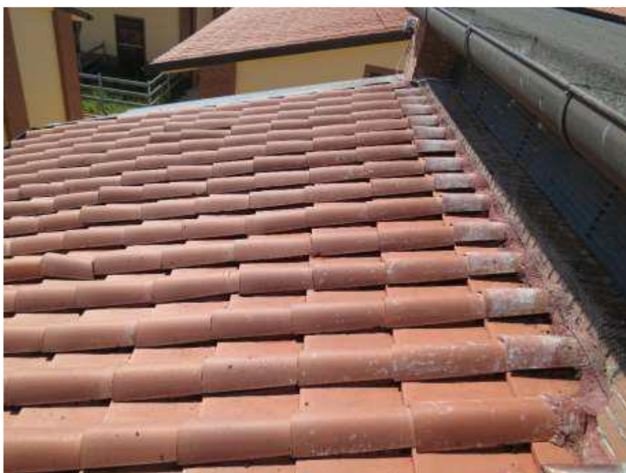
Figura 3. Tetto sud dopo la pulizia.
