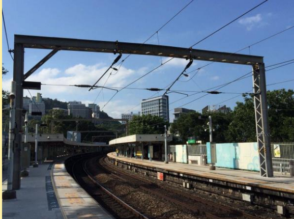
Bild 1 Signalbrücke mit Nestern
